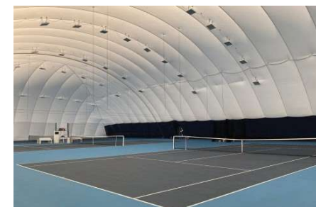
Courts de Tennis résine sous dôme
